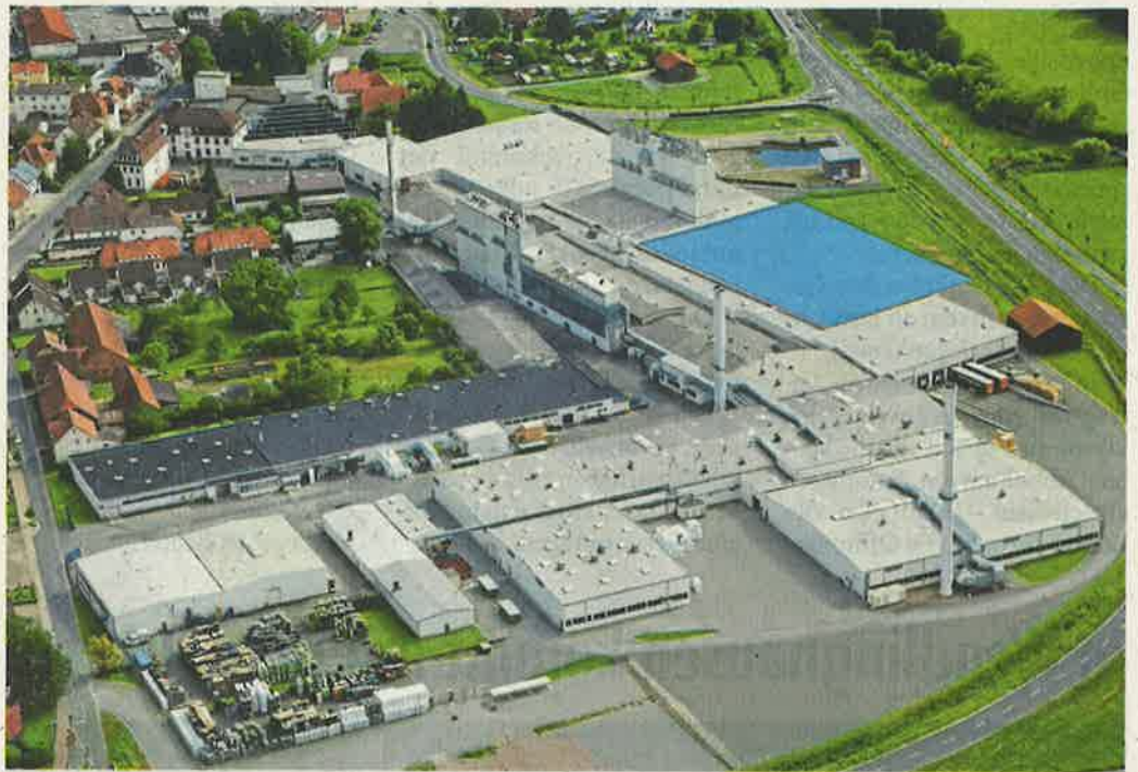
Im Luftbild blau markiert ist die Baulücke, in der die neuen Produktionsbereiche von SHWire entstehen sollen.
